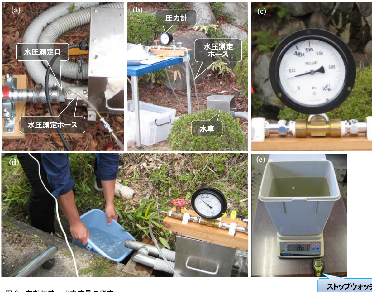
図 6 有効落差・水車流量の測定
