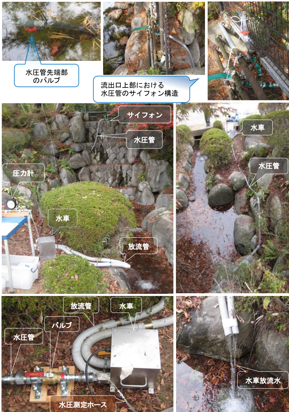
図 5 水車・水圧管等の設置状況
